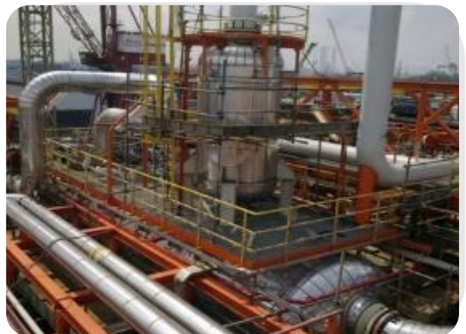
SEP-iSYS™ Separator on TGT FPSO.
