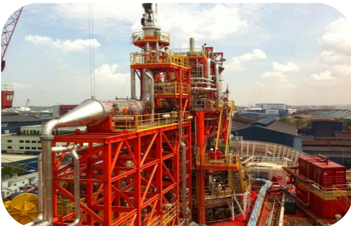
SEP-iSYS™ Separator on D1 FPSO.
